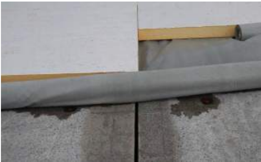
2 | Uitvoering van het dampscherm op TT-elementen.
