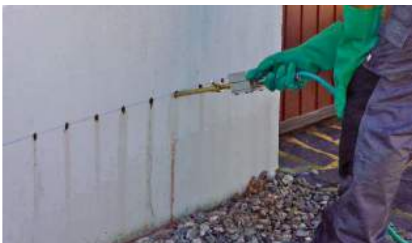
1 | Uitvoering van een injectiebehandeling tegen opstijgend grondvocht.
