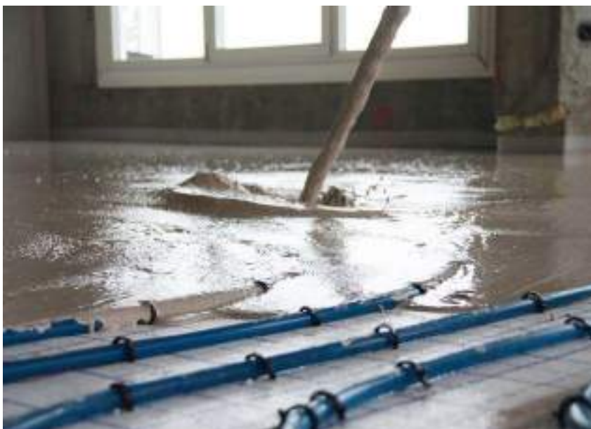
Uitvoering van een calciumsulfaatgebonden dekvloer.
